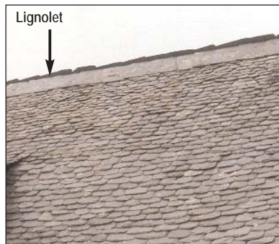
En haut, toiture à Le Playras (Bordenaves) en bas à gauche, détail de lignolet, à droite détail de coyau
