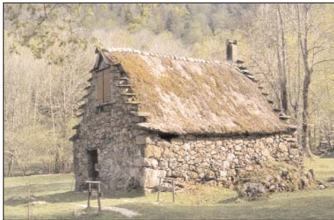
Saurat, toiture en chaume
