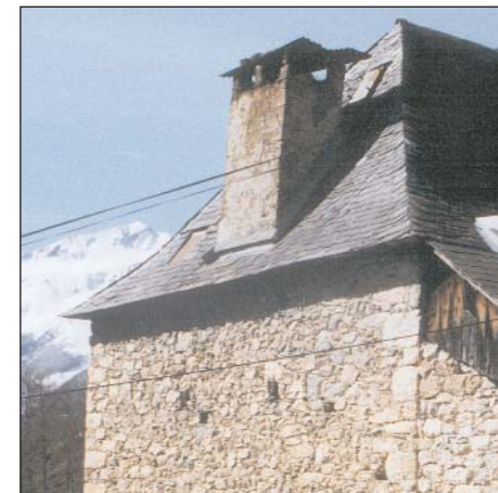
Cheminée massive sur un pan de toiture d'habitation à Uchentein.
