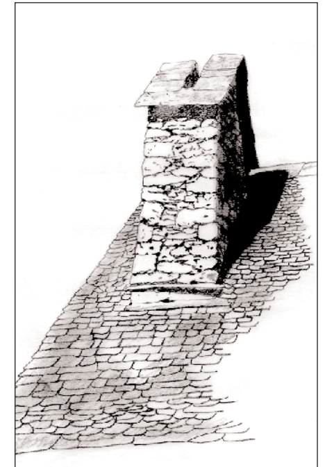
Cheminée avec couronnement bâti en mitre à Luentein, Biros
