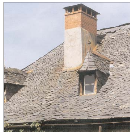
Balagué, modèle de capucines que l'on retrouve sur les habitations et souche de cheminée en brique couronnée par une tôle.
