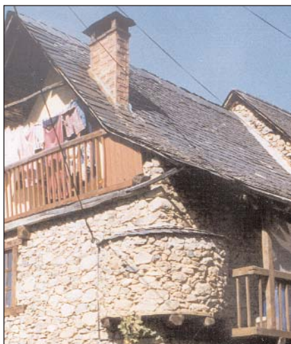
Four sphérique en encorbellement et souche de cheminée en brique de terre cuite à Samortein (vallée de Bethmale)
