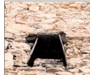
frazein (Biros) : sortie de conduit de four matérialisé par trois lauzes.
