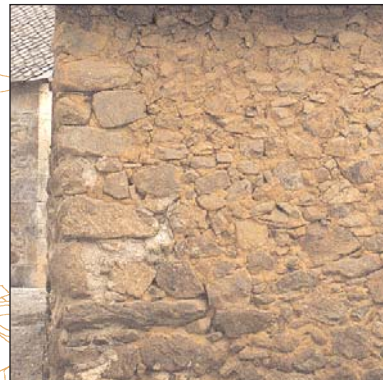
Appareillage en blocs de schistes et calcaires à Galey (à gauche), gneiss à Bethmale (à droite)
