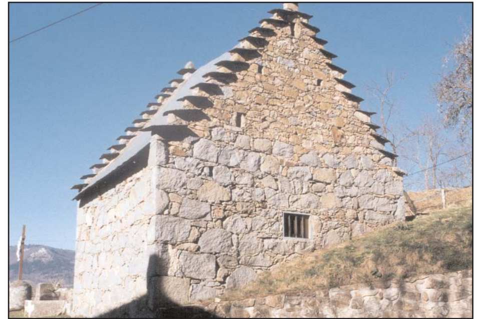
Grange au hameau du Touron, Col du Sarrailé : maçonnerie de pierre calcaire et de granit
