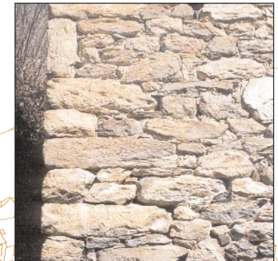
Appareillage en blocs de granit, Col du Sarraillé (à gauche), blocs de calcaire à Irazein (à droite)
