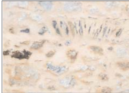
Exemples de joints de maçonnerie en creux à gauche, et de "remplissage", à droite
