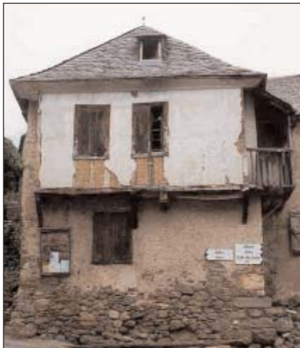
Arrien (vallée de Bethmale), ossature à pan de bois en encorbellement fermé à l'étage
