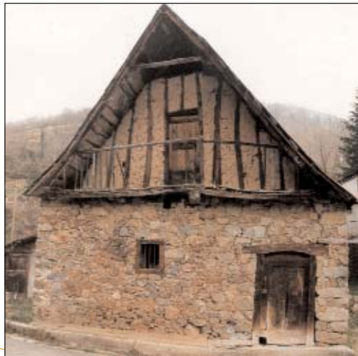
Ayet (vallée de Bethmale), ossature à pan de bois venant fermer le pignon en retrait du balcon
