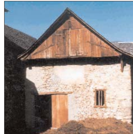
A gauche, bardage vertical à Balagué, à droite, clayonnage de branches de noisetier
